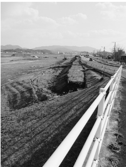
▲築堤工事の様子
