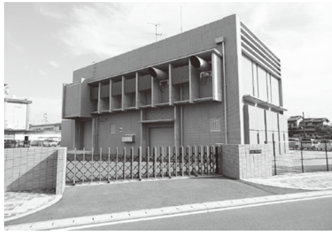
【役場庁舎裏に完成した排水機場】
