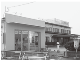
【建築中の院外薬局】
