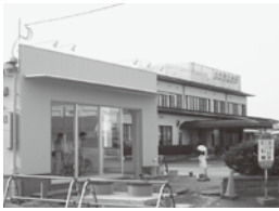
【建築中の院外薬局】
