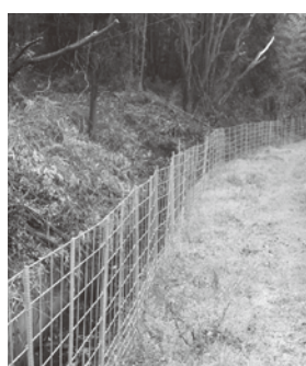
▲イノシシ侵入防止柵
