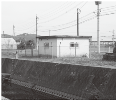
勝野揚水ポンプ場
