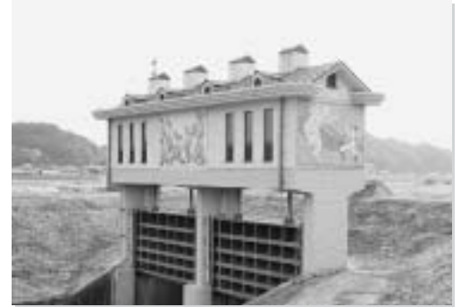
南良津川最下流の樋門
