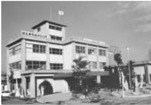
新庁舎 (昭和42年2月完成)
