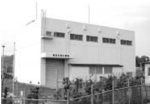
南良津排水機場
