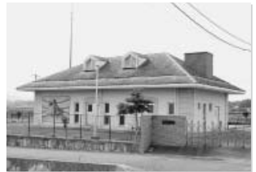
農業集落排水污水处理施設
