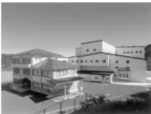
宮若市外二町じん芥処理施設組合 ごみ固形化燃料化施設
