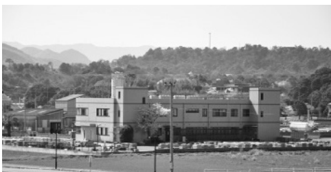
新庁舎建設予定地(旧福岡スプリットン社屋)
