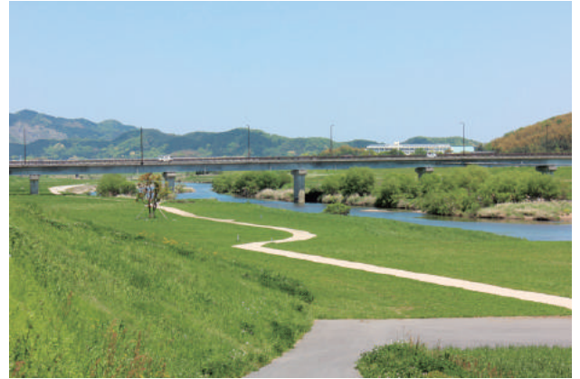
小竹駅まで続く遊歩道 遠賀川河川公園
