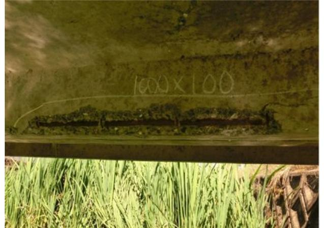
橋梁の損傷事例(鉄筋露出)
