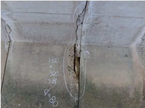
橋梁の損傷事例(断面欠損)
