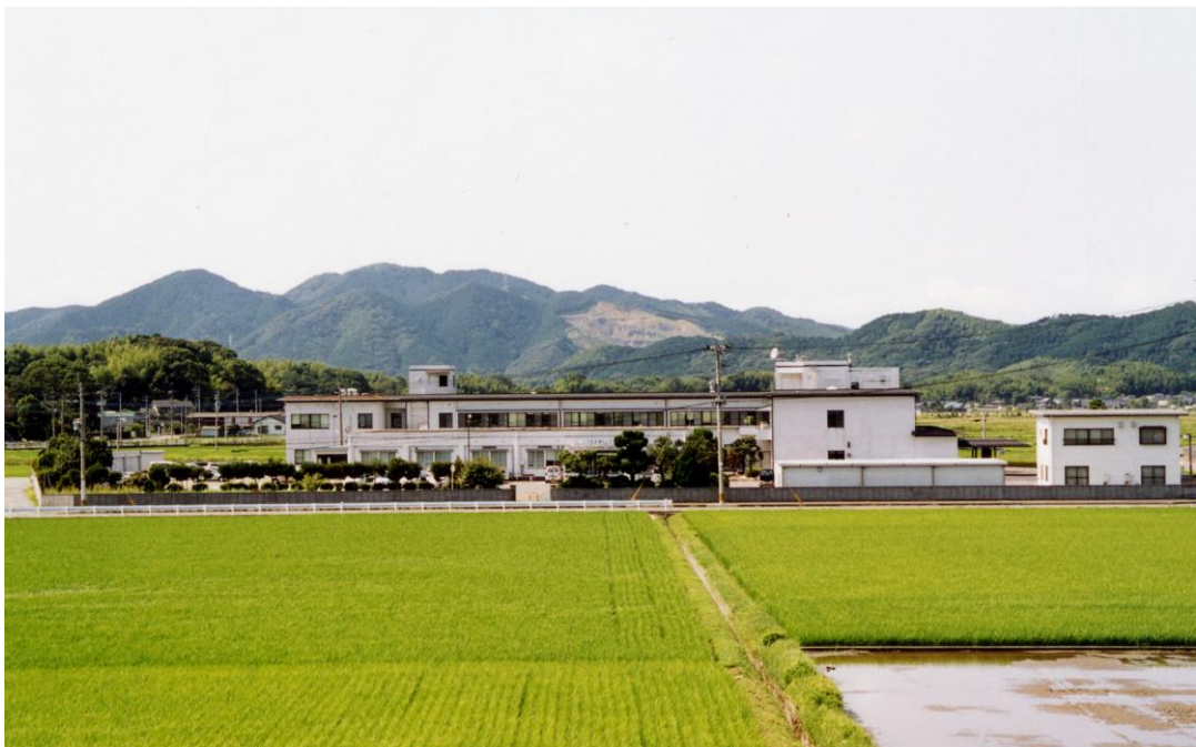
小竹町立病院・小竹町保健センター
