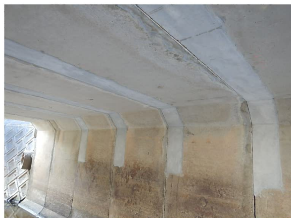
補修後の状況(井田橋)
